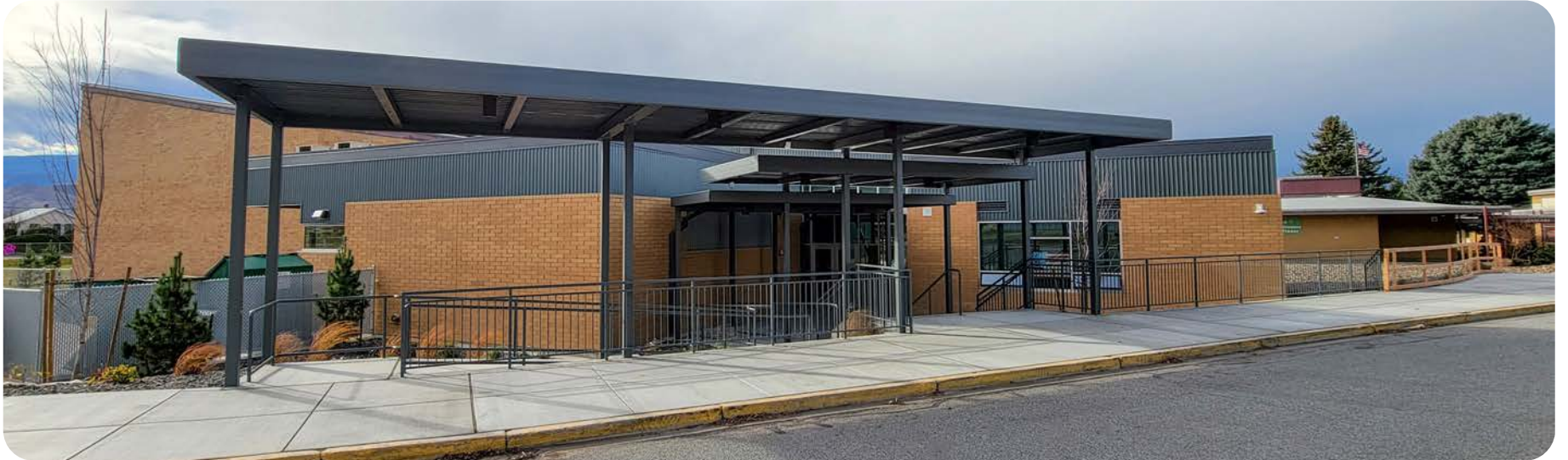
Fuera de la nueva cafetería de Cascade Elementary. La Fase 1 Capital Levy financió nuevas cafeterías y cocinas en cuatro escuelas primarias.
