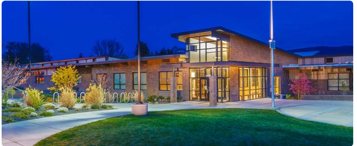
Modernización de la escuela secundaria Sterling Junior High
